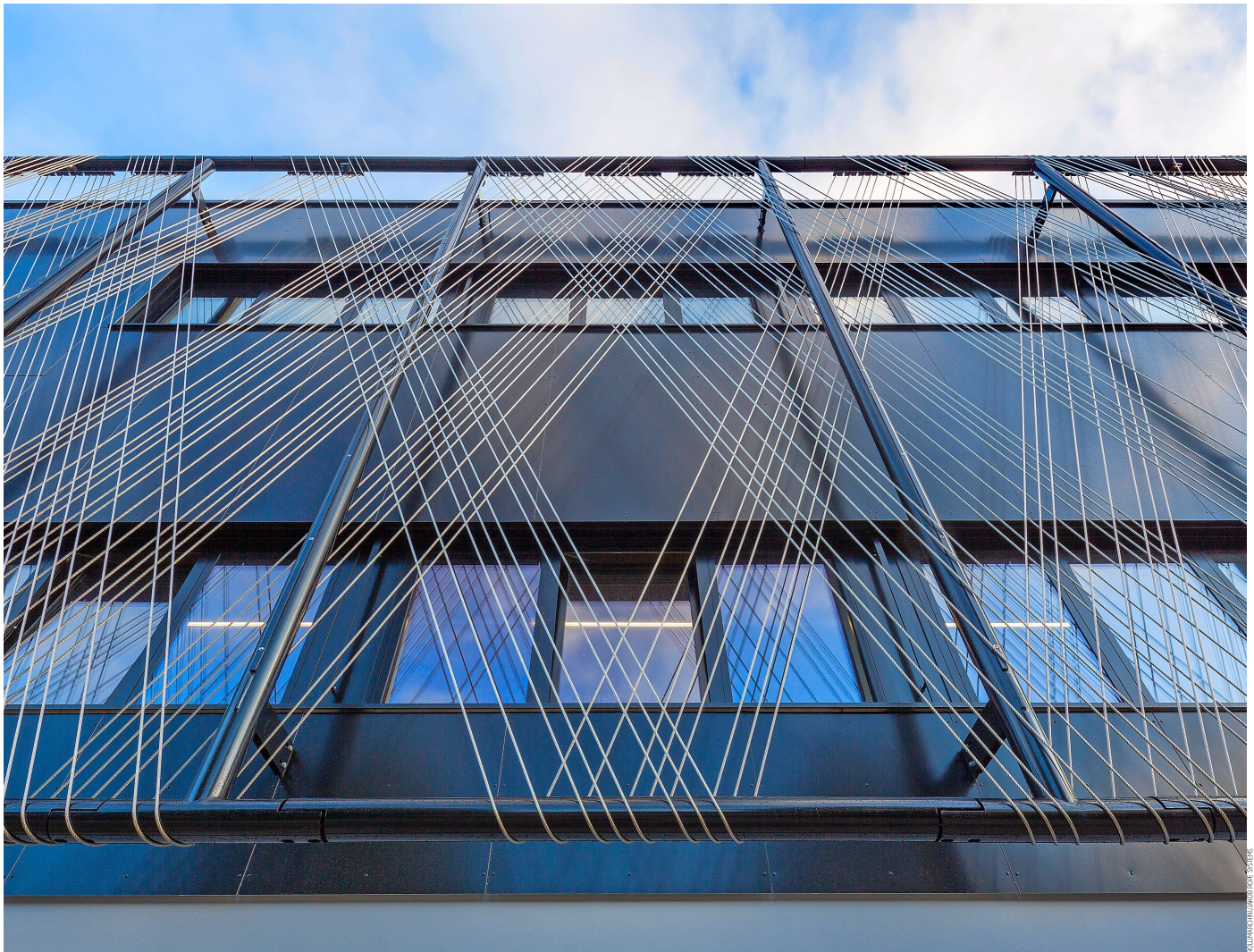
Seilstrukturen: Seile aus Edelstahl umgarnen den grossflächig befensterten Hauptsitz von Jakob Rope Systems in Trubschachen und verleihen diesem ein Design, das die Identität des Unternehmens transportiert.
