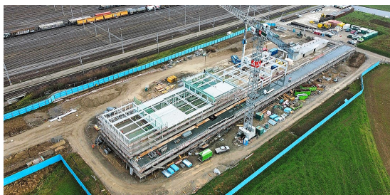
Limmattalbahn-Tramdepot «Müsli»: An der Grenze zwischen Dietikon und Spreitenbach entsteht ein Zweckbau mit einer Länge von 145 Metern, einer Breite von 24 Metern und einer Höhe von 11 Metern. In Betrieb geht es ab Dezember des kommenden Jahres.
