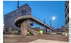
Negrellisteg, Zürich: Bauherrschaft: Schweizerische Bundesbahnen SBB und Stadt Zürich. Architektur und Tragwerksplanung: ARGE Conzett Bronzini Partner/Diggelmann + Partner AG/10.8 Architekten GmbH, Zürich und Chur. Stahl- und Metallbau-Unternehmen: Officine Ghidoni SA, Rizzano.
