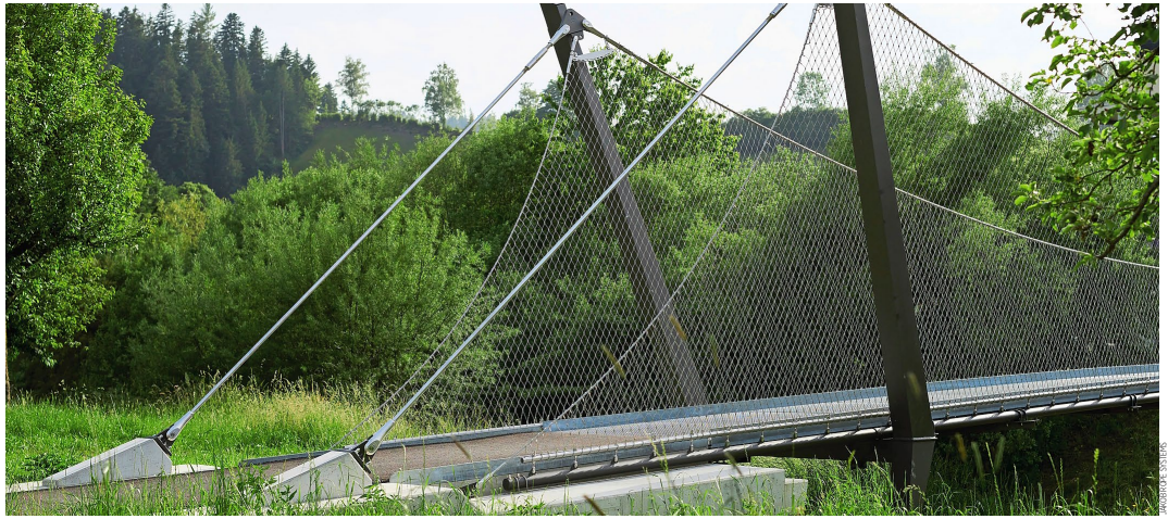
Brückenbau: Edelstahlseile und -netze für die Architektur ermöglichen innovative Leichtbaustrukturen. Demonstriert wird dies seit 2021 mit der Hängebrücke über die Trueb.
